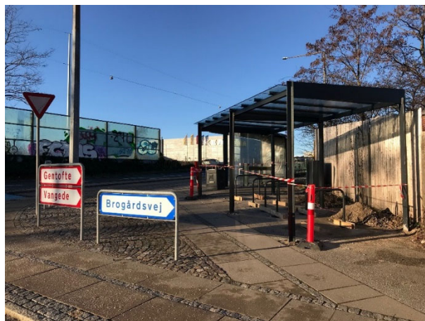
Den nye cykeloverdækning på Lyngbyvejs lokalgade syd for Brogårdsvej. En tilsvarende cykeloverdækning er etableret på modsatte side af motorvejen på Lyngbyvejs lokalgade syd for Brogårdsvej.
